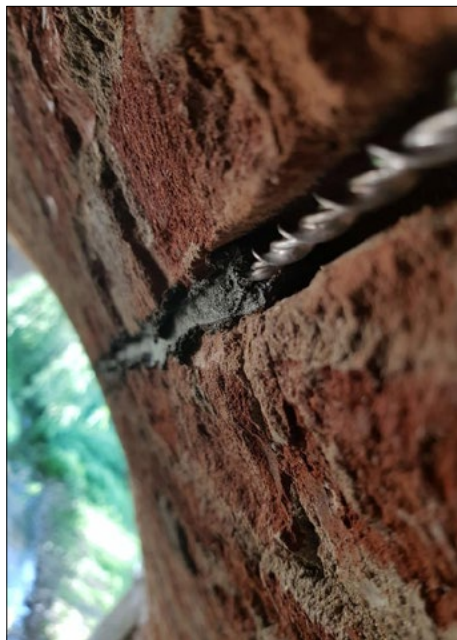
Obr. 27: Vkládání helikální výztuže do připravené štěrbiny s první vrstvou malty.
