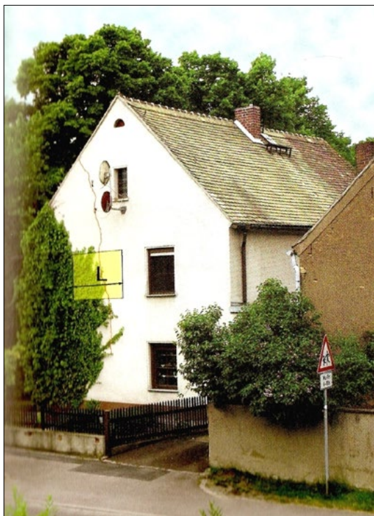
Obr. 67: Jednotná trhlina ve štítu (obkreslená), odhadovaná tažná délka L je zakreslena
